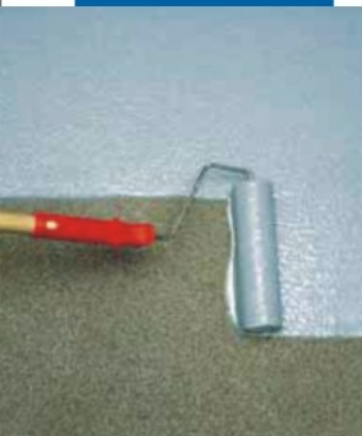
Thi công Mapecoat I 24 bằng cọ lăn
