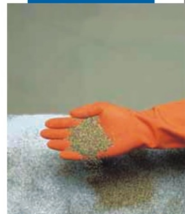
Trải cát khô lên sản phẩm Mapecoat I 24
