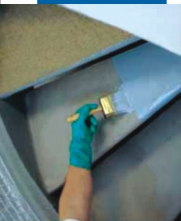
Thi công lớp Mapecoat I 24 thứ nhất trên bê tông
